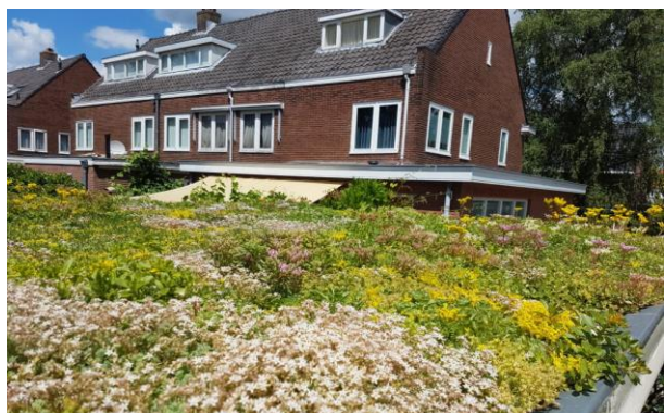
Aangelegd sedumdak door Samen Duurzaam Zeist
