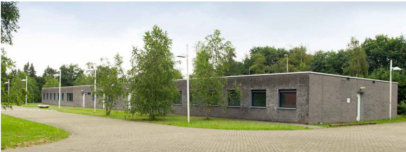
Het eenlaagse woongebouw De Aarde (beelden: Stichting in Arcadië, 2017 en Bureau Nieuwe Gracht, 2019).
