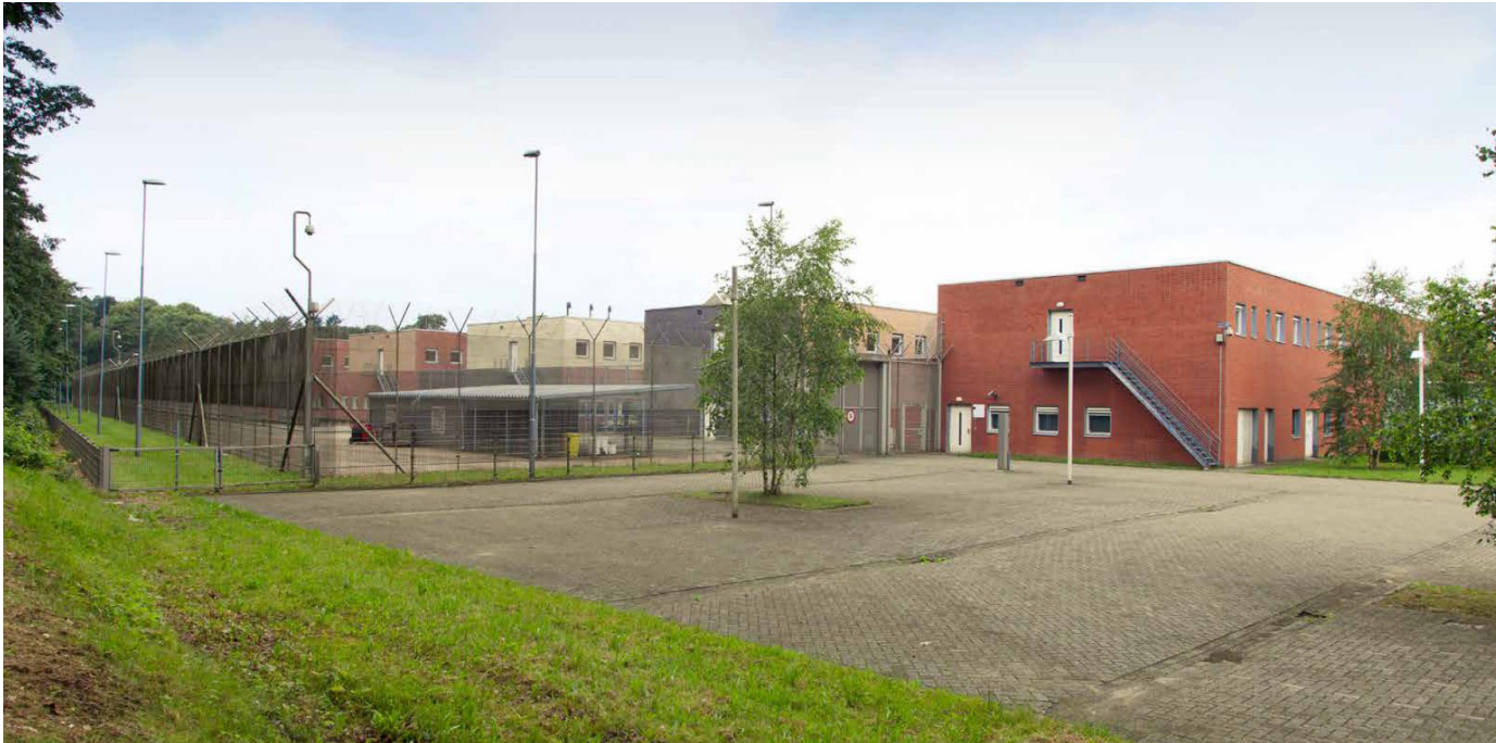
Het hoofdgebouw van de penitentiaire jeuginrichting met het parkeerterrein op de voorgrond.
