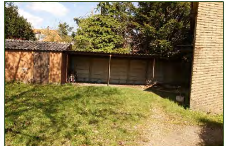
Fig. 2.6 Schuurtje en overkapping, naast woning (bron: FF Solutions)
