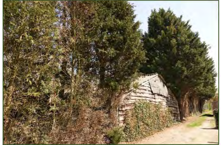
Fig. 2.10 Achterzijde houten schuur (bron: FF Solutions)
